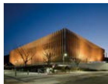
인천아시아경기대회 강화경기장_CM 이가ACM건축사사무소
